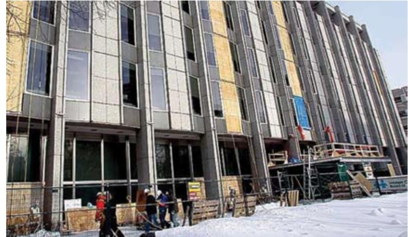
Image 46. *Réhabilitation* de l'enveloppe extérieure, notamment par le retrait de tous les panneaux de revêtement en granite en vue de l'installation d'une nouvelle isolation extérieure devant l'acier porteur. L'espacement de 125 mm qui en résulte est compensé par un profilé en acier inoxydable sur les élévations latérales. Commission des accidents du travail, Winnipeg (Manitoba).
