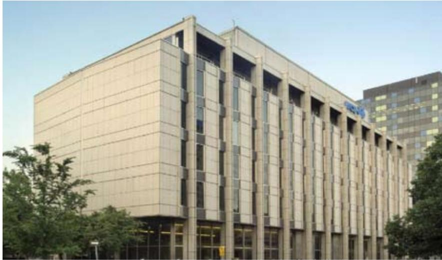
Le bâtiment de la Commission des accidents du travail rénové. Les joints de dilatation en acier inoxydable sont visibles sur la façade est ainsi qu'à la base des colonnes.
