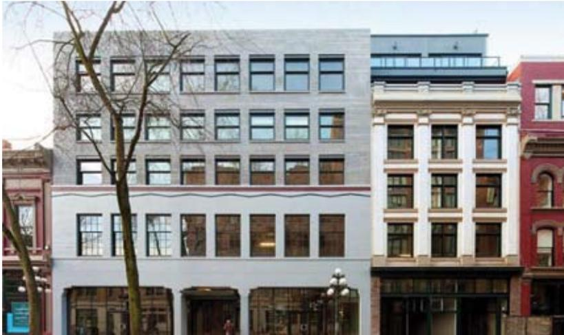
Image 48. Devantures de magasin réhabilitées avec impostes. Le vitrage le plus élevé de la devanture laisse pénétrer la lumière plus loin à l'intérieur du rez-de-chaussée. Vancouver (Colombie-Britannique). Source : Acton Ostry.
