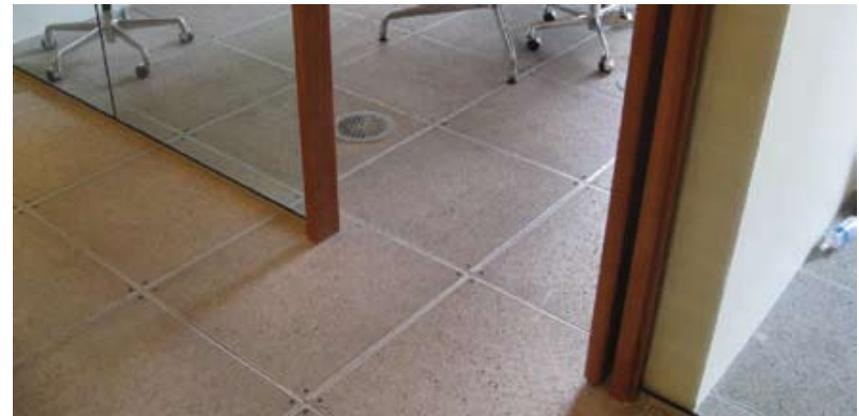
Image 63. Faux-plancher installé à l'intérieur d'un bâtiment historique. Ancienne usine McGregor Socks (désormais les bureaux de Stantec), Toronto (Ontario). Source : MTBA Associates Inc.
