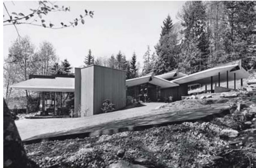
Image 36. De longues toitures à faible pente sur les espaces intérieurs et extérieurs créent de l'ombre et donnent à la maison sa forme distincte. Forest House, Ron Thom. Source : AZNModern
