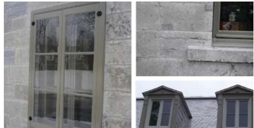
Du coin supérieur gauche : installation d'une nouvelle contre-fenêtre inspirée du modèle d'origine pour améliorer le rendement de la fenêtre existante. Maçonnerie rejointoyée et réparée. Lucarnes réhabilitées et nouvelles fenêtres.
