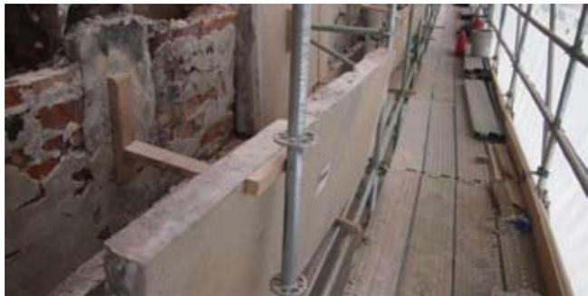
Image 77. Revêtement en calcaire, renfort en maçonnerie et structure en acier, chaque élément influençant les deux autres. Édifice Sir-John-A.-Macdonald, Ottawa (Ontario). Source : MTBA Associates Inc.
