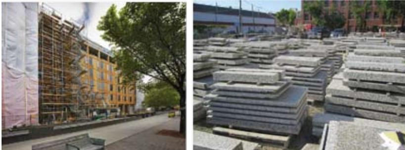
De gauche à droite : les contreplaqués temporaires offrent une protection contre les éléments durant la construction et les palissades forment une enceinte de confinement durant le retrait de l'amiante; en tout, 4 044 panneaux en granit d'origine ont été nettoyés, catalogués et entreposés à l'extérieur du chantier.
