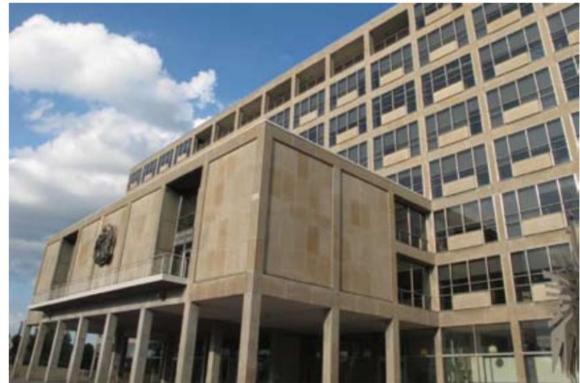
Image 54. La salle du conseil, en projection, agrémentée d'un balcon, protège l'entrée principale sous-jacente. Ancien hôtel de ville d'Ottawa, Ottawa (Ontario). Source : MTBA Associates Inc.
