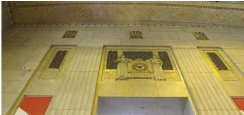
Image 62. Les grilles de ventilation en plâtre ornemental du comptoir bancaire principal étaient initialement raccordées à de grands ventilateurs situés au-dessus et derrière celles-ci. Les grilles ont été réhabilitées et intégrées au nouveau système mécanique à titre de grilles d'échappement. Édifice Sir-John-A.-Macdonald, Ottawa (Ontario). Source : MTBA Associates Inc.
