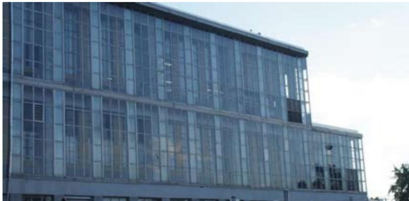
Image 43. Mur-rideau extérieur en verre de l'Imprimerie nationale du Canada (vers 1950). Le mur-rideau fait partie d'un assemblage à double paroi permettant de mieux contrôler les conditions intérieures des aires d'impression et de production. Gatineau (Québec). Source : MTBA Associates Inc.
