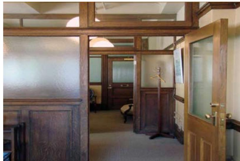
Image 1. Les cloisons intérieures de cet immeuble de bureaux de 1908 comportent des vitres givrées ou à motif qui laissent pénétrer la lumière tout en préservant l'intimité. La consommation d'électricité pour l'éclairage artificiel s'en trouve ainsi réduite. Fiducie du patrimoine ontarien, 10, rue Adelaide, Toronto (Ontario).
