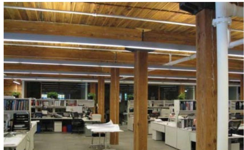
Image 78. La structure en bois et le plancher ont été conservés dans le cadre de ce projet de réutilisation adaptative. Ancienne usine McGregor Socks (désormais les bureaux de Stantec), Toronto (Ontario). Source : MTBA Associates Inc.
