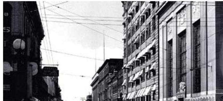
Image 50. Photographie d'époque de l'édifice Booth (deuxième bâtiment à droite) sur la rue Sparks, à Ottawa. Il est important de reconnaître que les fenêtres étaient autrefois composées de nombreux éléments contribuant à leur rendement. Dans le cas présent, les fenêtres de la façade sud étaient protégées contre les apports de chaleur intense par des auvents en tissu accessibles depuis les fenêtres à châssis ouvrant. Édifice Booth, Ottawa (Ontario). Source : Ottawa AA
