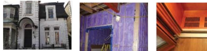
De gauche à droite : la résidence avant sa réhabilitation; photo de l'isolant du mur intérieur prise pendant la construction; détail d'un grillage de ventilation à l'intérieur d'une double-fenêtre du mur sud.
