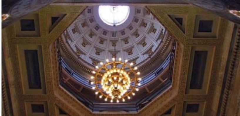
Image 37. Vue intérieure d'un dôme à double paroi du siège social de la Banque de Montréal, un élément caractéristique qui permet la stratification de l'air et un accès à la lumière naturelle, Montréal (Québec). Source : MTBA Associates Inc.
