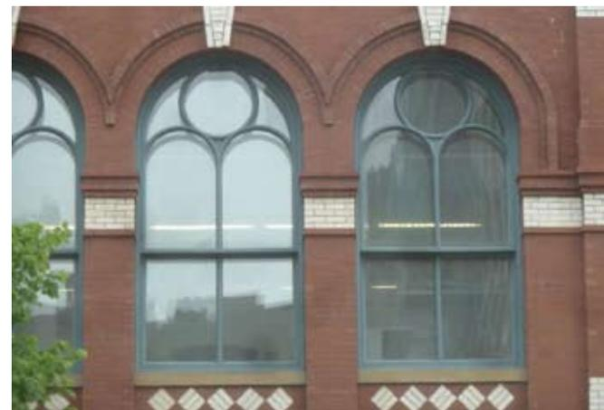
Détail de fenêtre sur la rue King : des pellicules écoénergétiques ont été installées à l'intérieur pour augmenter le rendement thermique, tout en préservant ces *éléments caractéristiques* (source : Jim Bezanson).
