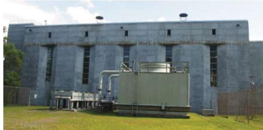
Image 35. Élévation nord illustrant l'ajout ultérieur d'un refroidisseur sans égard à la forte axialité et au plan de style Beaux-Arts du bâtiment, un élément caractéristique de la propriété « classée » par le BEÉFP. Imprimerie nationale et chaufferie, Gatineau (Québec). Source : MTBA Associates Inc.
