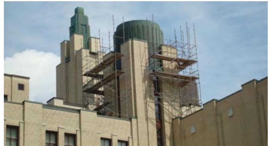
Image 76. Projet de réhabilitation de l'enveloppe extérieure d'un mur en maçonnerie en cours. Université de Montréal, Montréal (Québec).
