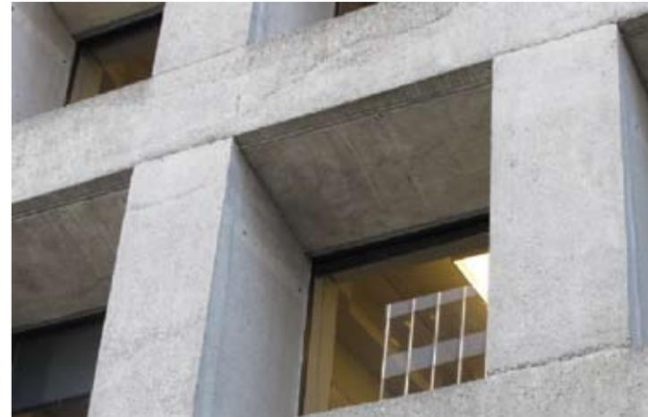
Image 80. Façade en béton coulé en place. MacMillan Bloedel Building, Vancouver (Colombie-Britannique). Source : MTBA Associates Inc.
