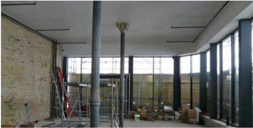
Image 70. Espace commercial au rez-de-chaussée en voie de *réhabilitation*. Le plafond a été rehaussé à la hauteur d'origine de façon à exposer les chapiteaux de colonne décoratifs et à permettre l'installation de plus grandes fenêtres de devanture de magasin, qui laisseront la lumière naturelle pénétrer plus loin dans l'espace. Édifice Dineen, Toronto (Ontario). Source : Urban Toronto
