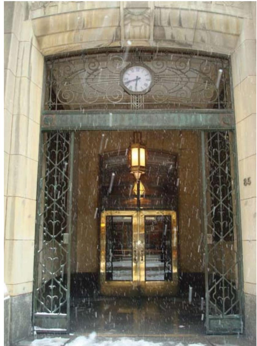
Image 53. Un portique et un vestibule intégrés à la séquence d'entrée d'un bâtiment commercial. Le portique sert de protection contre les intempéries, tandis que le vestibule isole l'intérieur de l'extérieur. Édifice Aldred, Montréal (Québec).
