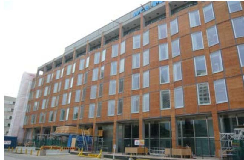
Image 24. Enveloppe extérieure entièrement réhabilitée. Cette image montre la progression de la réhabilitation, au cours de laquelle des panneaux en granite ont été temporairement retirés pour permettre l'installation de l'isolant neuf et d'effectuer d'autres mises à niveau de l'enveloppe. Pour en savoir plus sur cette réhabilitation, consultez l'étude de cas en annexe. 333, Broadway, Winnipeg (Manitoba). Source : Winnipeg Architecture Foundation
