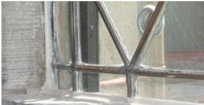
Image 51. Détail de fenêtre comportant des meneaux mastiqués, une garniture d'étanchéité périmétrique et une contre-fenêtre extérieure ventilée. Musée canadien de la nature, Musée commémoratif Victoria, Ottawa (Ontario). Source : Shelley Bruce
