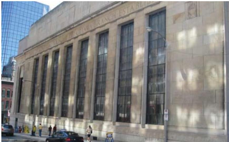
Image 47. On a conservé et réhabilité ces grandes fenêtres (fenêtres et contre-fenêtres) à double vitrage à cadre en bronze pour préserver la principale source de lumière dans le respect de la construction d'origine. Les seules améliorations énergétiques étaient l'ajout de nouvelles garnitures d'étanchéité sur les fenêtres à châssis ouvrant intérieures, ce qui a rehaussé leur durée de vie. Édifice Sir-John-A.-Macdonald, Ottawa (Ontario). Source : MTBA Associates Inc.
