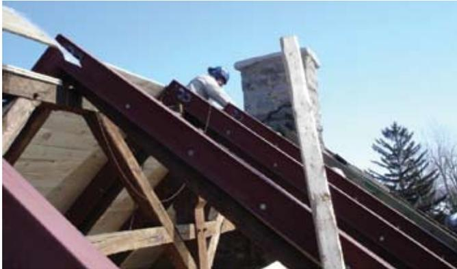
Renforcement de l'ossature du toit en bois d'œuvre à l'aide de membrures d'acier.
