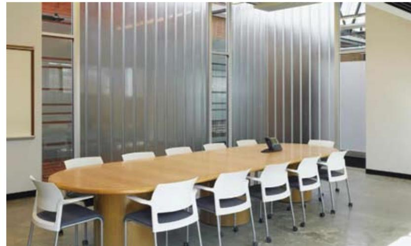
Image 74. De nouvelles cloisons vitrées délimitent une salle de réunion et permettent à la lumière naturelle de pénétrer dans la pièce depuis un espace central doté d'un puits de lumière. Triffo Hall. Source : Barry Johns Architecture Limited
