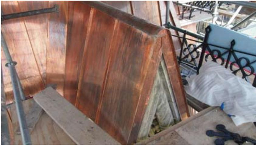
Image 40. Bordure de toit dont on a modifié la hauteur pour installer un nouvel isolant. Ces modifications permettent d'améliorer le rendement de l'enveloppe du bâtiment, tout en réduisant considérablement l'impact visuel. Édifice de l'Est, Colline du Parlement, Ottawa (Ontario). Source : MTBA Associates Inc.
