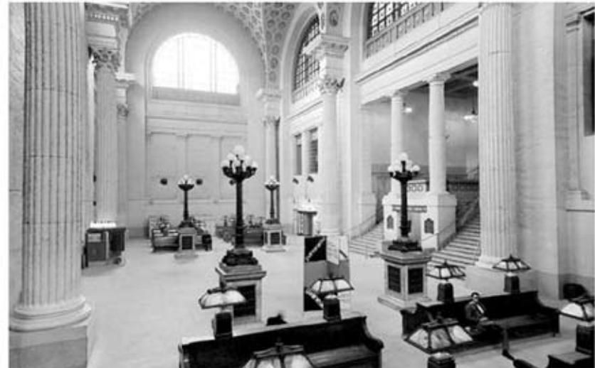
Image 5. Salle d'attente de la gare Union construite en 1912, à Ottawa. Image prise vers 1950, montrant les systèmes CVCA intégrés au mobilier et aux éléments de conception (c.-à-d., bancs et bornes d'éclairage). Source : Archives, Commission de la capitale nationale
