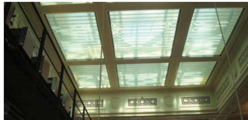
Image 57. Grand puits de lumière central d'un comptoir bancaire. Il procure de la lumière naturelle à l'intérieur du comptoir, qui est situé au centre d'un pâté de maisons et a donc un accès limité aux fenêtres sur rue. Le puits de lumière a été mis à jour durant la réhabilitation de l'ancienne Banque Scotia à Ottawa, en Ontario. Source : MTBA Associates Inc.
