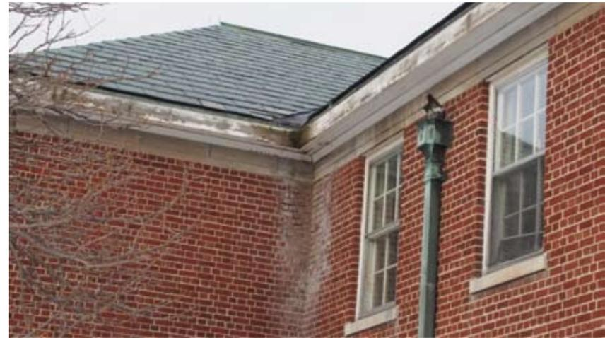
Image 42. À cause de la dégradation des gouttières, les murs extérieurs, surtout aux coins intérieurs, ont été exposés à des volumes d'eau beaucoup plus grands provenant de la noue. Par conséquent, le mortier est défaillant et le recouvrement en brique s'effrite. De plus, l'eau de pluie ne peut plus être recueillie pour l'entretien du terrain. École Sagonaska, Sir James Whitney School, Belleville (Ontario). Source : MTBA Associates Inc.
