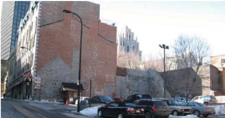
Image 32. Exemple de détérioration urbaine dans lequel on peut suivre l'évolution de la construction dans la propriété contiguë. Les modifications apportées aux bâtiments adjacents risquent d'exposer des murs qui n'étaient jamais destinés à l'être. Montréal (Québec). Source : MTBA Associates Inc.
