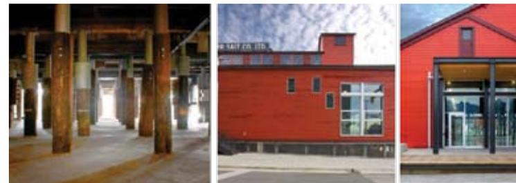
De gauche à droite : le bâtiment a été soulevé d'un mètre à l'aide de 300 faux pieux métalliques; vue des pieux et des fenêtres, nouvelles et anciennes; façade restaurée et nouvelle aire couverte.
