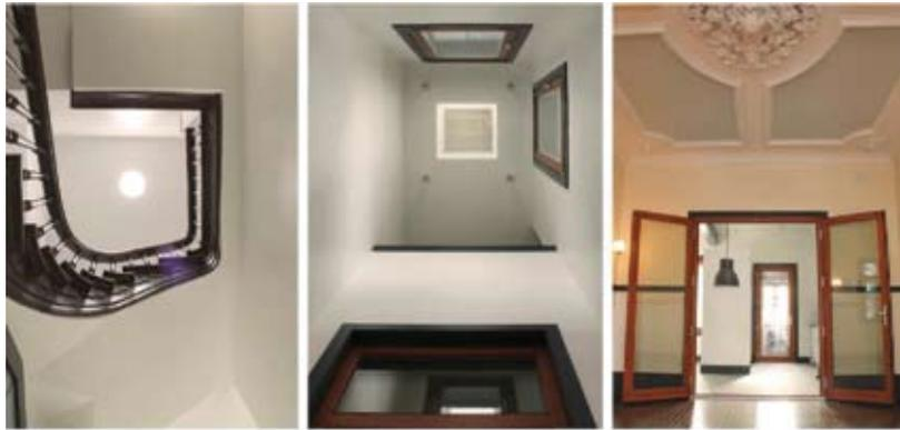
De gauche à droite : des puits de lumière éclairent naturellement le centre du bâtiment; l'intérieur de la tourelle procure un refroidissement passif; préservation de caractéristiques intérieures comme le plafond en plâtre et la cage d'escalier.
