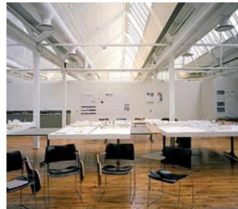
Image 43. Le revêtement de plafond et le plancher en bois franc ont été conservés dans le cadre de la réhabilitation d'une ancienne usine riveraine transformée en bâtiment institutionnel. On remarque l'utilisation efficace de la lumière naturelle grâce aux fenêtres à claire-voie, ce qui réduit les coûts énergétiques. École d'architecture de l'Université de Waterloo, Cambridge (Ontario).
